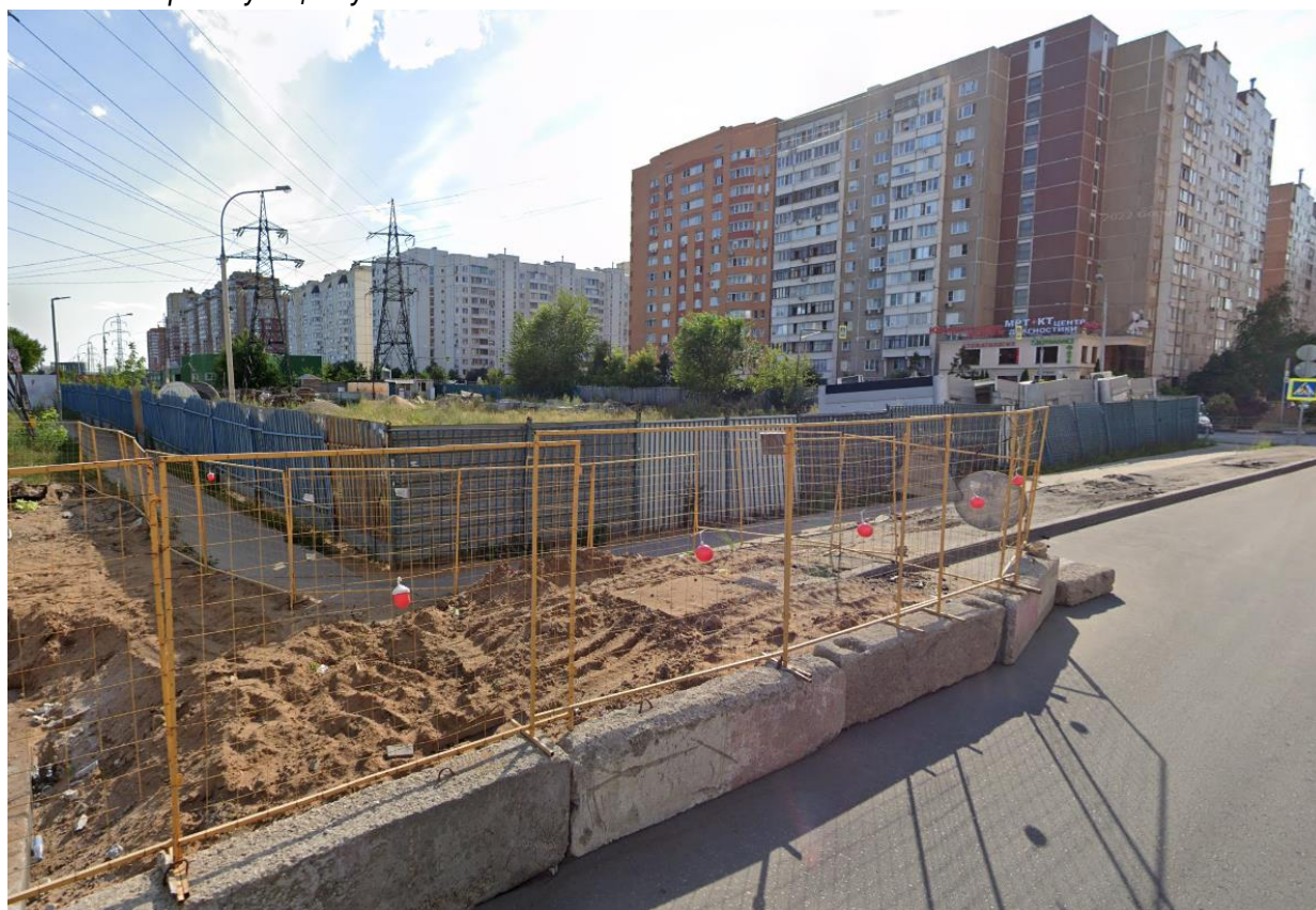
Рисунок 4.1, 4.2 – Фотофиксация существующего состояния территории
